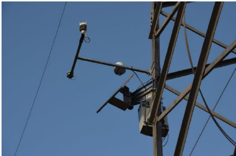
Slika 2.1.1. Meterološka stanica postavljena na zateznom stubu [2]
